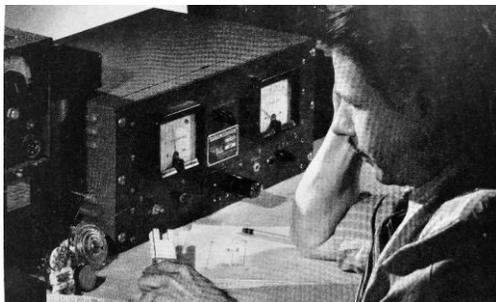
**Figura 2.** Em certos equipamentos de radiocomunicações profissionais e militares, as válvulas eram meticulosamente avaliadas e selecionadas, uma a uma. Foto: testes na Raytheon, que se especializou no fornecimento de equipamentos para aplicações aviônicas.
