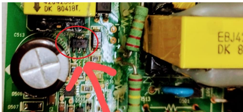
Fig. 3 – Parte da Y-SUS onde vemos o MOSFET chaveador da fonte de 18V danificado
